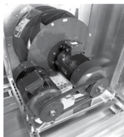
С резервным двигателем
